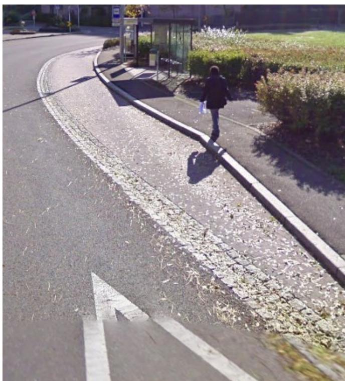
Arrêt de bus juste avant un virage. Les autobus articulés se tiennent debout avec la partie arrière sur la route.
